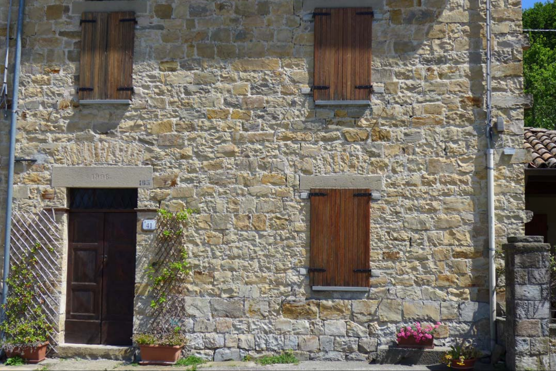
Muratura in pietra ricavata dal flysch
